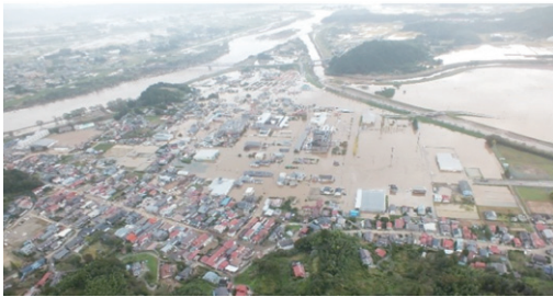
令和元年東日本台風による浸水被害 宮城県丸森町 (山形県消防防災航空隊提供)
